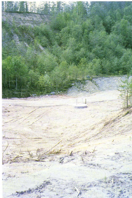
Kuva 2. Usein pohjavesikaivot sijoitetaan teknis-taloudellisista syistä entisiin maa-ainestenottoaikkoihin, kuten kuvan Kuusimäen vedenottamo. Valokuva Jukka Virtanen.
