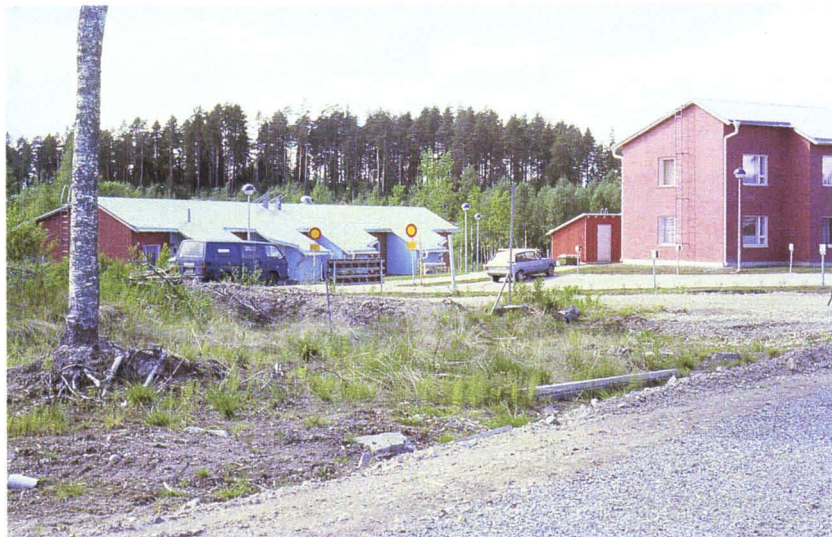
Kuva 1. Jordanin asuntoalueen maaperä kartoitettiin, jotta rakennukset osattiin suunnitella otollisimmille rakennuspaikoille. Kuvan pienkerrostalot on perustettu hyvin kantavalle, edulliselle maapohjalle. Valokuva Jukka Virtanen.
