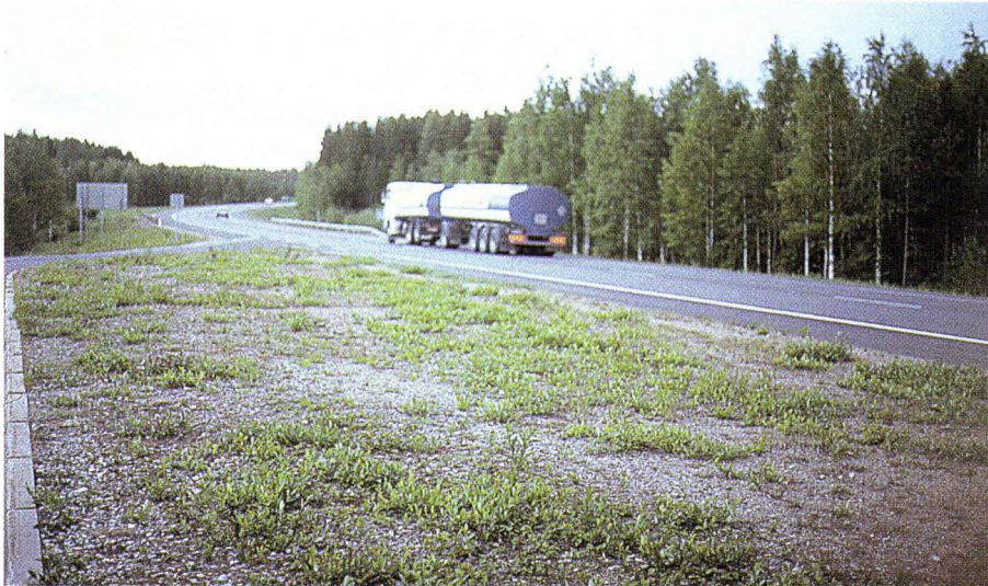
Kuva 18. Iisalmen tärkeä kulkuväylä — viitostie — kulkee ajoittain hyvin vettäläpäisevällä maapohjalla, kuten kuvassa. Onnettomuuden sattuessa tällaisella alueella on pohjaveden saastumisriski suuri. Valokuva Jukka Virtanen.
