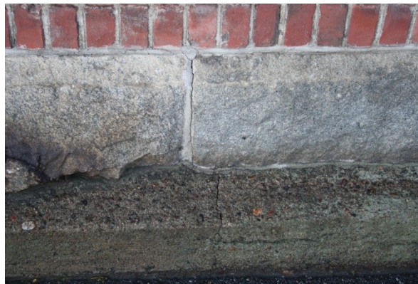
Kuva 14.2. Kivijalan betoninen alaosa.
