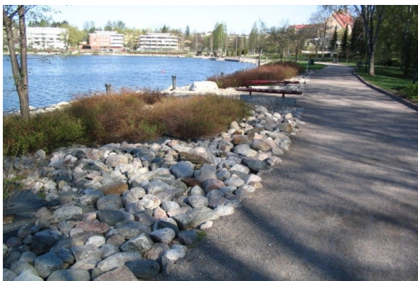
Kuva 9.1. Puistokäytävän reunan mukulakiviä.
