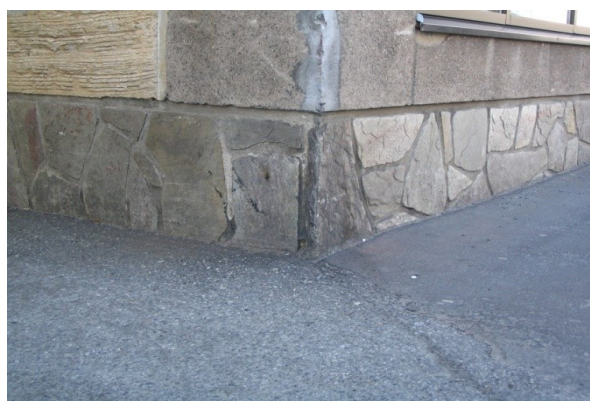
Kuva 12.2. Kvartsiittilaattoja kivijalassa.
