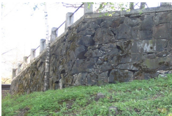
Kuva 9.3. Kivimuuri ja kaidetolppakivet.
