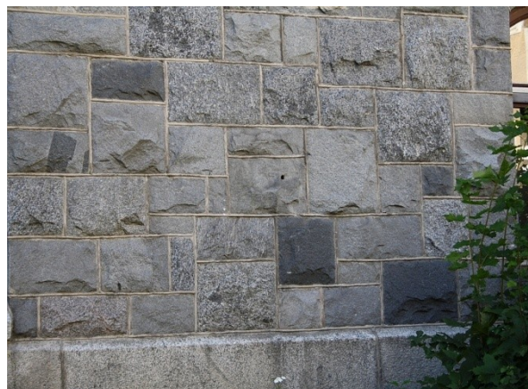
Kuva 11.4. Seinän rubble-muuri
