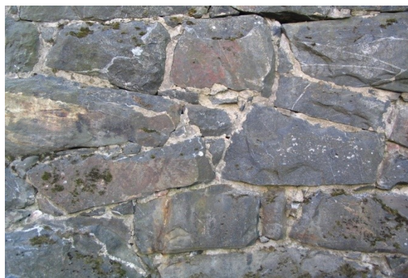
Kuva 9.4. Kivimuurin kiviä ja kalkkilaastia.
