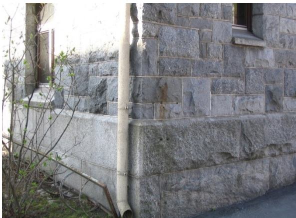
Kuva 11.3. Lohkopintainen ja piikattupintainen sokkeli.
