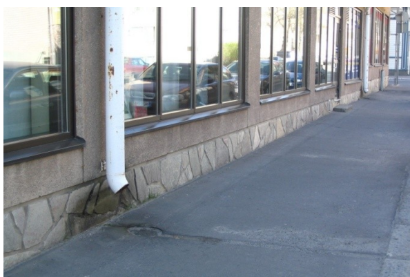
Kuva 12.1. Kvartsiittilaatoilla verhoiltu kivijalka.
