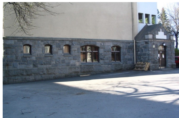
Kuva 11.2. Entisen Lääninsairaalan pohjoispääty.
