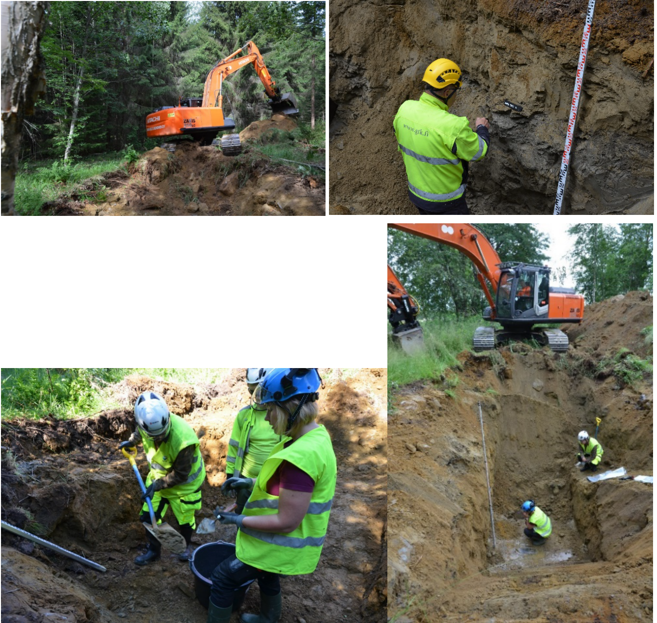
Kuva 29. Montutustyötä Kuukkelin alueella.
