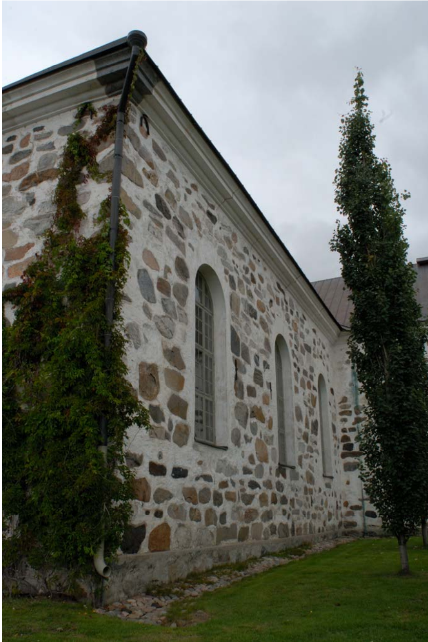
Kuva 9. Kuopion tuomiokirkon eteläsiiven kiviseinää (Kuva: Jari Väätäinen)
