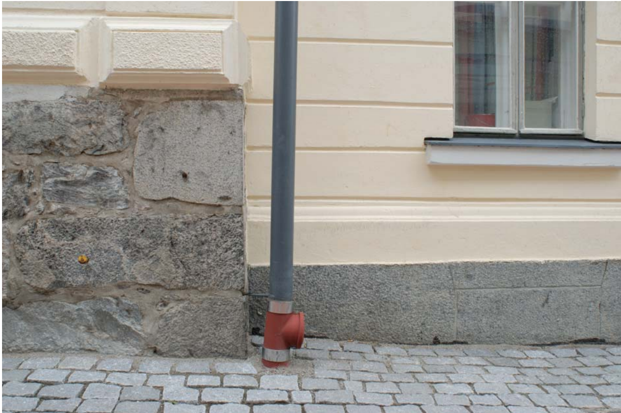
Kuva 2. Lyseon Hallikadun puoleiset kivijalat. Vesiputken vasemmalla puolella kivijalka on vuodelta 1875 ja oikealla puolella vuodelta 1914 (Kuva: Jari Väättäinen).
