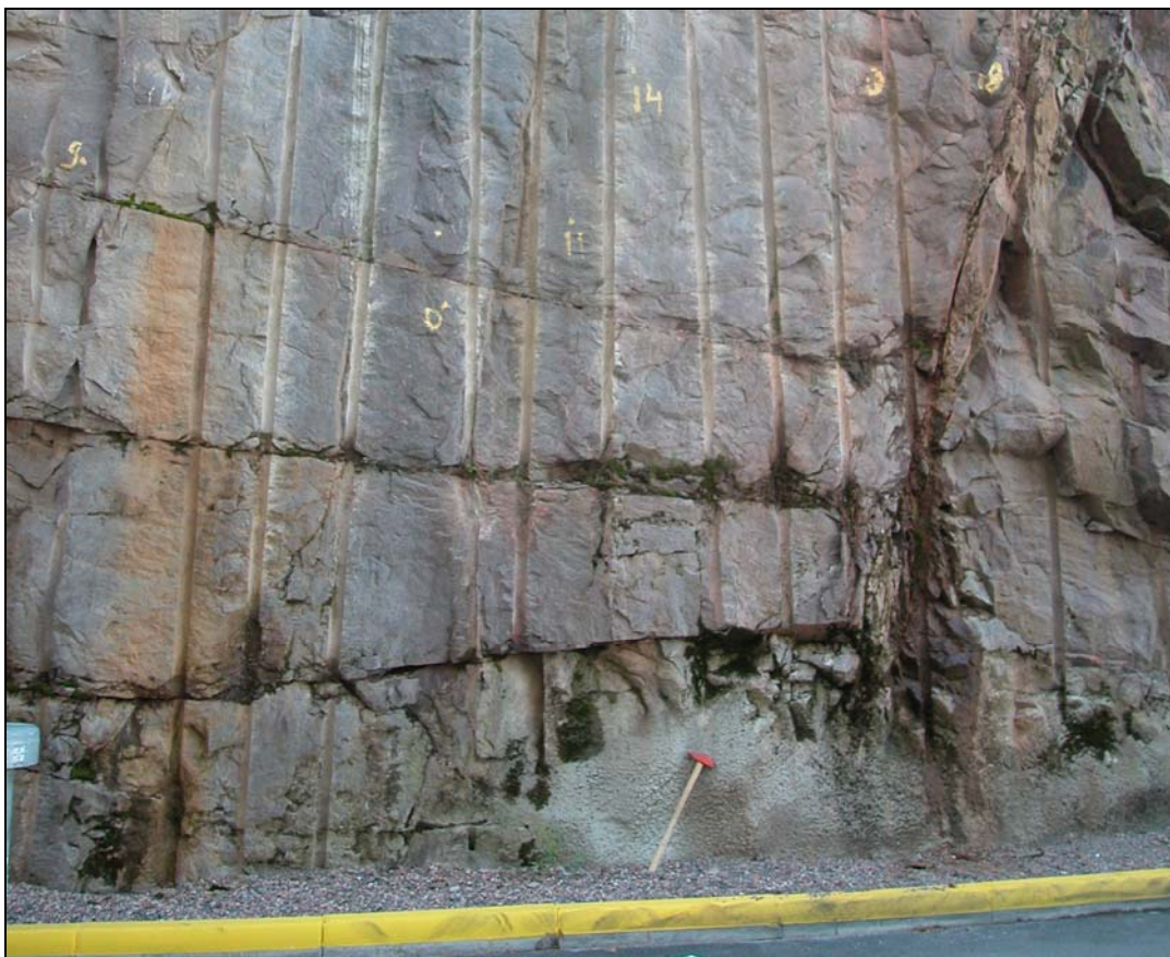
Kuva 6. Systemaattista vaakarakoilua graniitissa Tapiolan terveysaseman parkkipaikalla. Havainto METU-2007-29.
