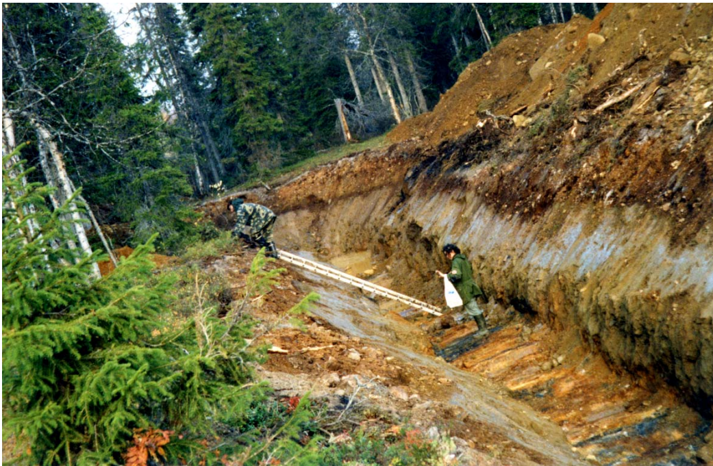
Kuva 9. Näytteenotto tutkimusojassa M10. Rapakallion päällä on yksi moreenipatja. (Kuva Vilho Mäntynen 2001)
